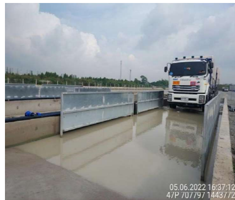
ภาพที่ 2-12 ล้างล้อก่อนออกจากพื้นที่โครงการ
